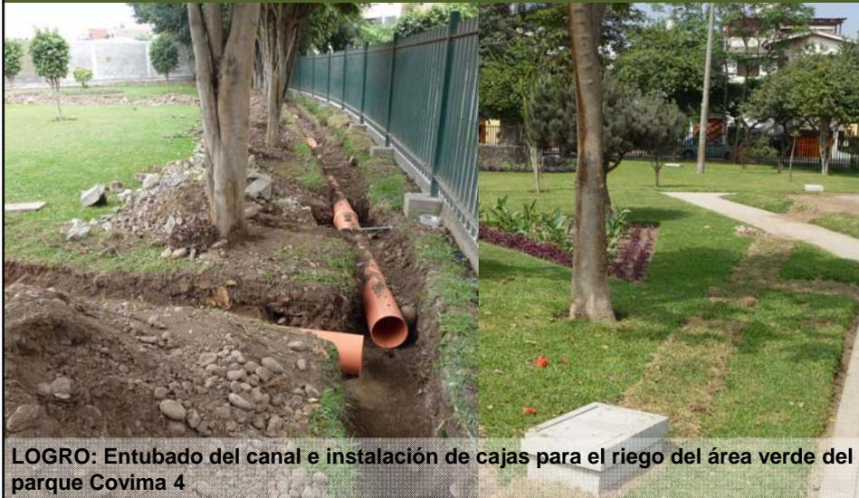
**LOGRO:** Entubado del canal e instalación de cajas para el riego del área verde del parque Covima 4
