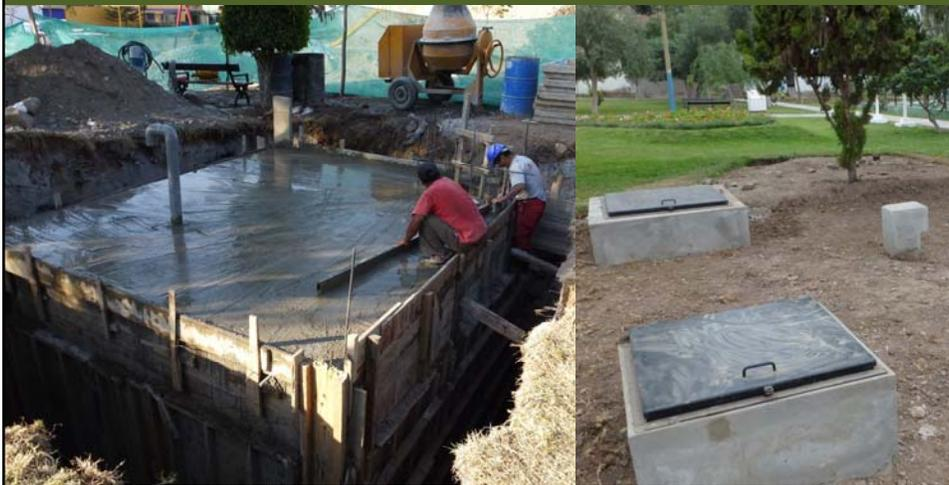
**LOGRO:** Construcción de cisterna de 30 m<sup>3</sup> e instalación de electrobomba de 8 hp con lo que tendrá asegurada su dotación de agua para el riego
