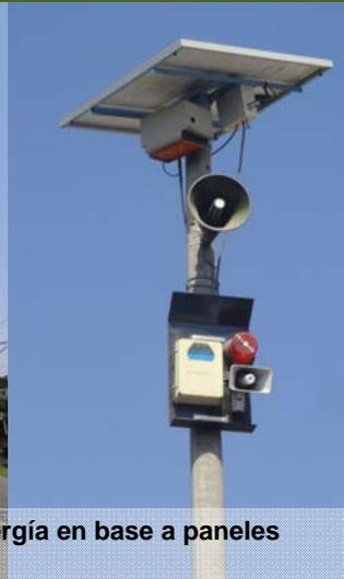
**LOGRO:** Instalación de seis alarmas con fuente de energía en base a paneles solares.
