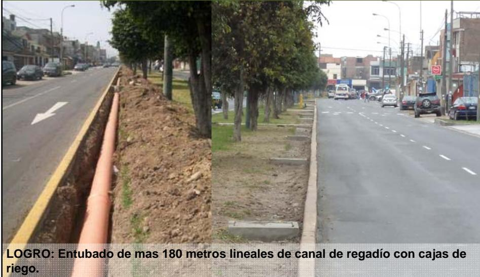
**LOGRO:** Entubado de mas 180 metros lineales de canal de regadío con cajas de riego.
