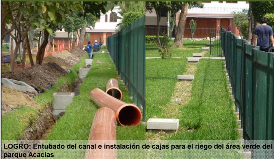
**LOGRO:** Entubado del canal e instalación de cajas para el riego del área verde del parque Acacias
