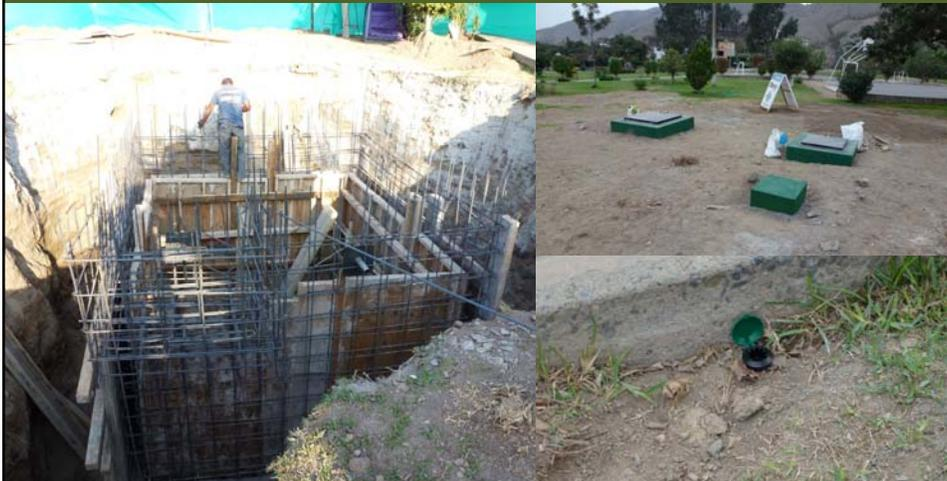
**LOGRO:** Construcción de cisterna de 40 m<sup>3</sup> e instalación de electrobomba de 10 hp con lo que tendrá asegurada su dotación de agua para el riego
