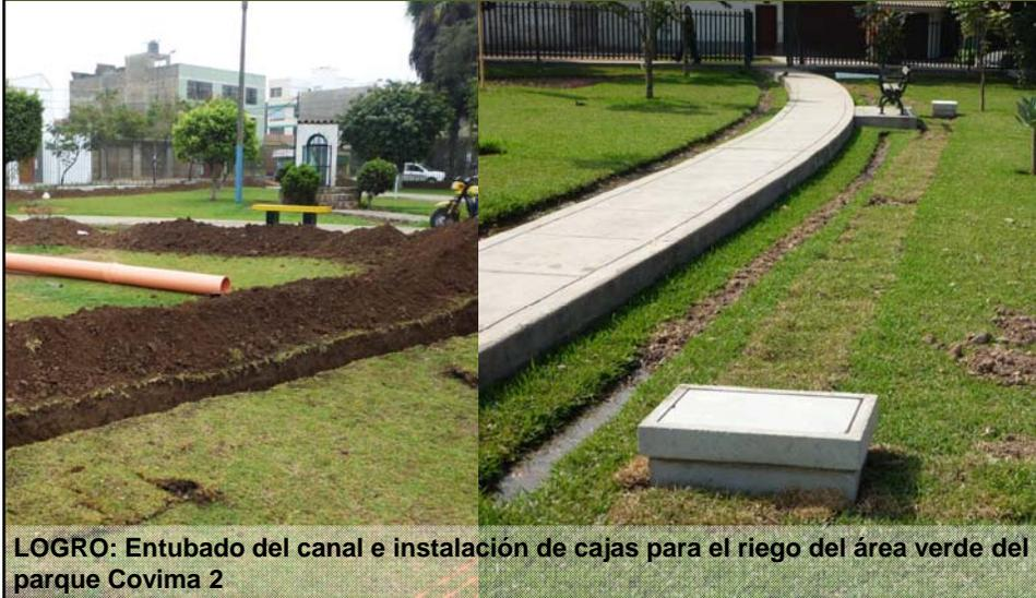
**LOGRO:** Entubado del canal e instalación de cajas para el riego del área verde del parque Covima 2
