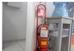
El extintor se encuentra en buen estado, operativo y con carga vigente
