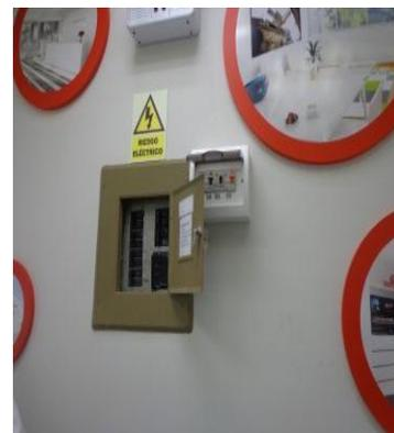
Tablero eléctrico de metal con Interruptores termo magnéticos
