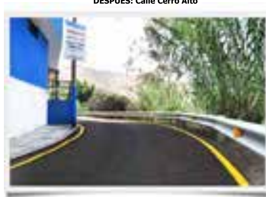
DESPUES: Calle Cerro Alto
