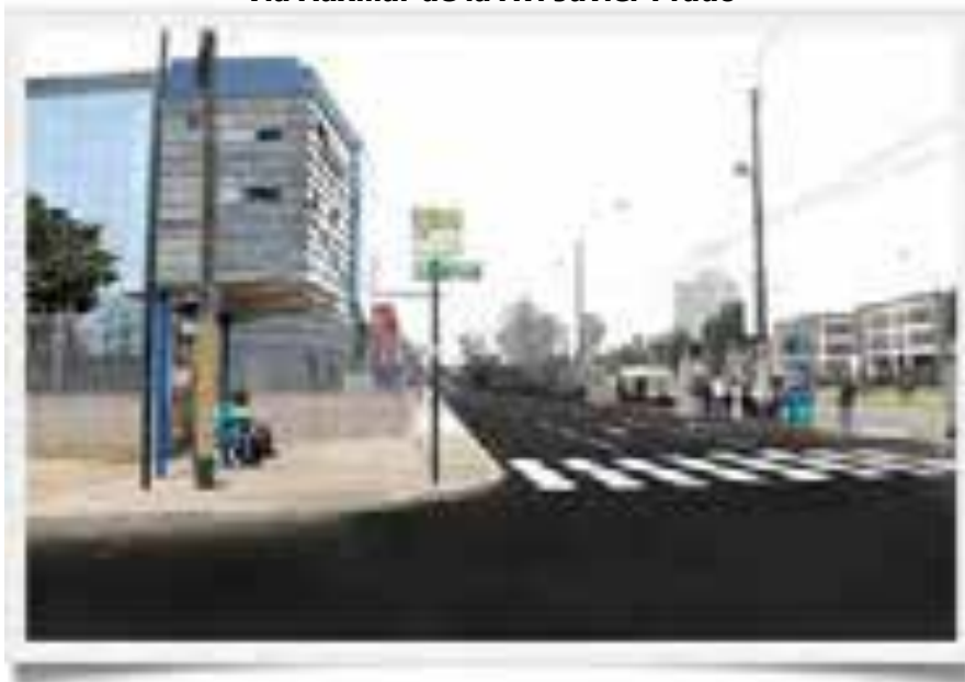
Vía Auxiliar de la Av. Javier Prado
