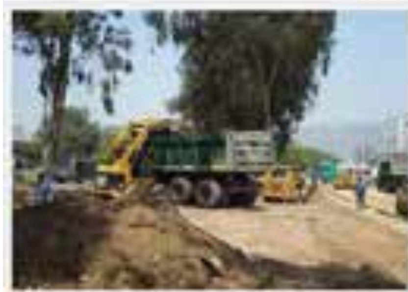
SERVICIO DE ELIMINACION DE DESMONTE
