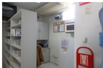
Los equipos eléctricos tienen tomacorrientes con conexión al sistema de puesta a tierra así como enchufes de tres espigas
