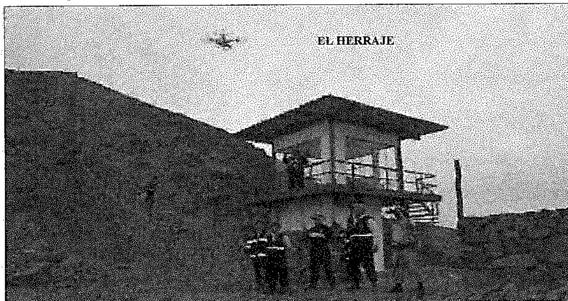
Instalación de (04) Torres de Vigilancia: CIMA 1, CIMA 3, El Herraaje y Parque Ecológico
