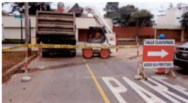
Eliminación de desmonte con equipo pesado
