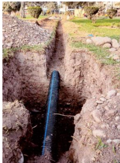
Instalación de tubería HDPE
