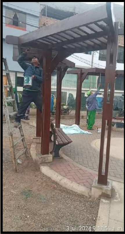
MANTENIMIENTO DE PERGOLAS
