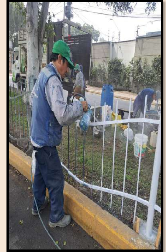
MANTENIMIENTO DE REJAS
