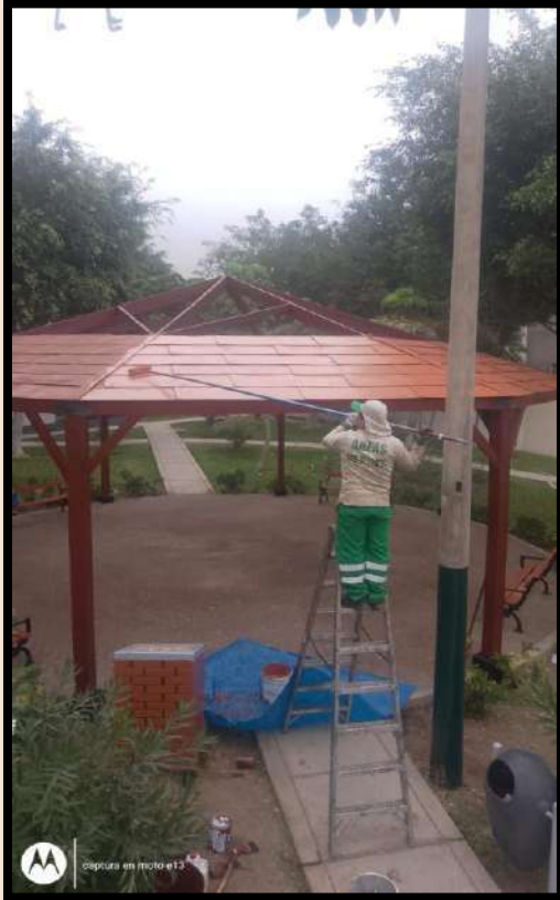
MANTENIMIENTO DE PERGOLAS
